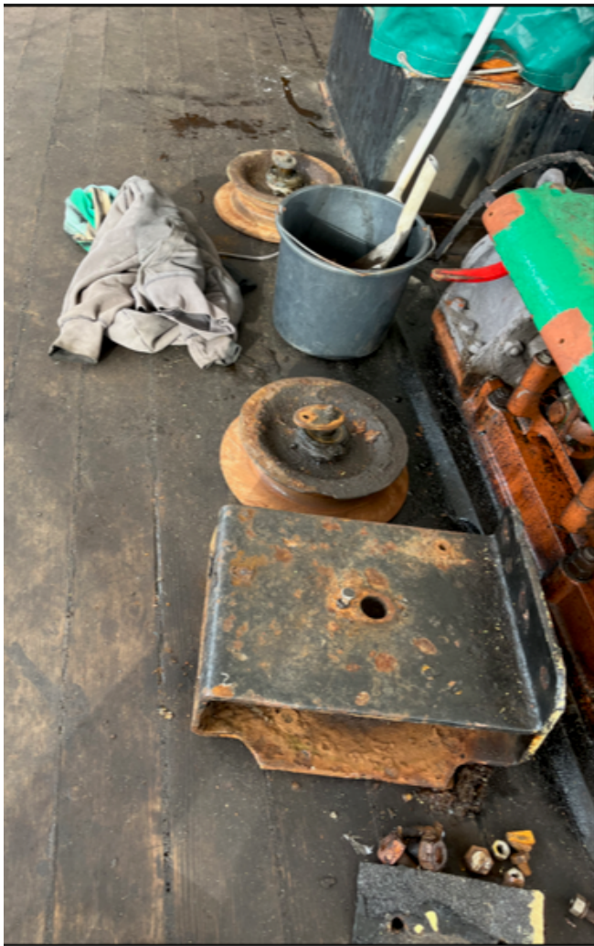
lejer for styrekæden afmonteret for maling
