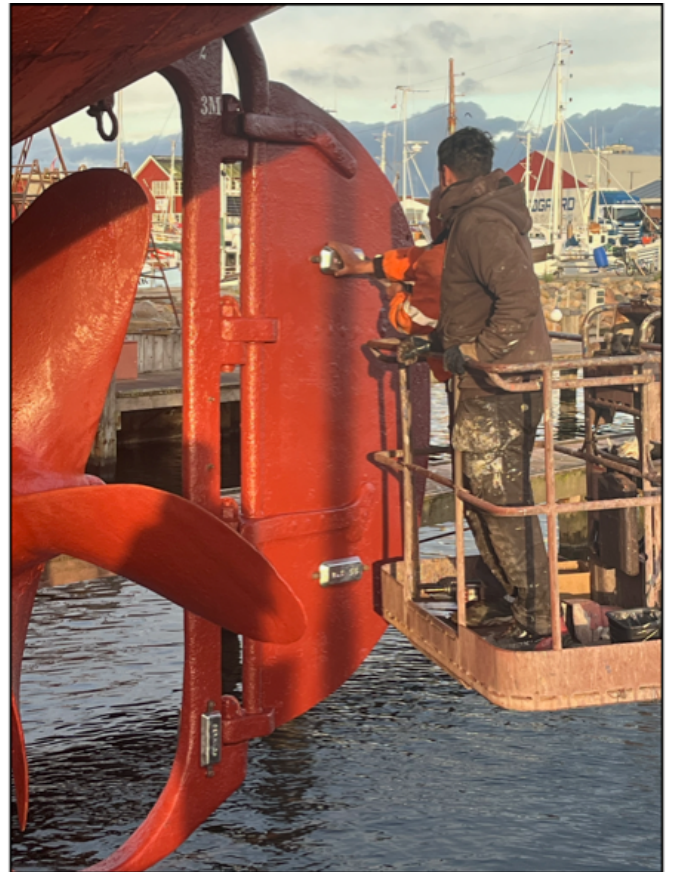
Tæreklodser monteres fra lift
